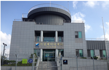
레이더 테스트베드 전경
